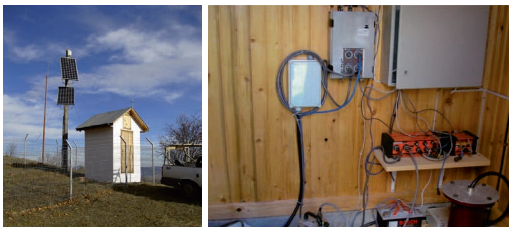
Imaginea unei stații seismice în exterior (stânga) și interior (dreapta)
